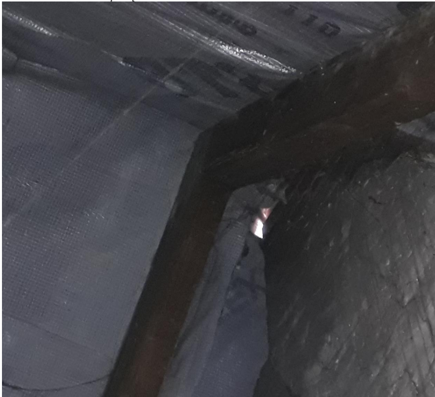
Fot3: Nieszczelne połączenie dachu i komina:
