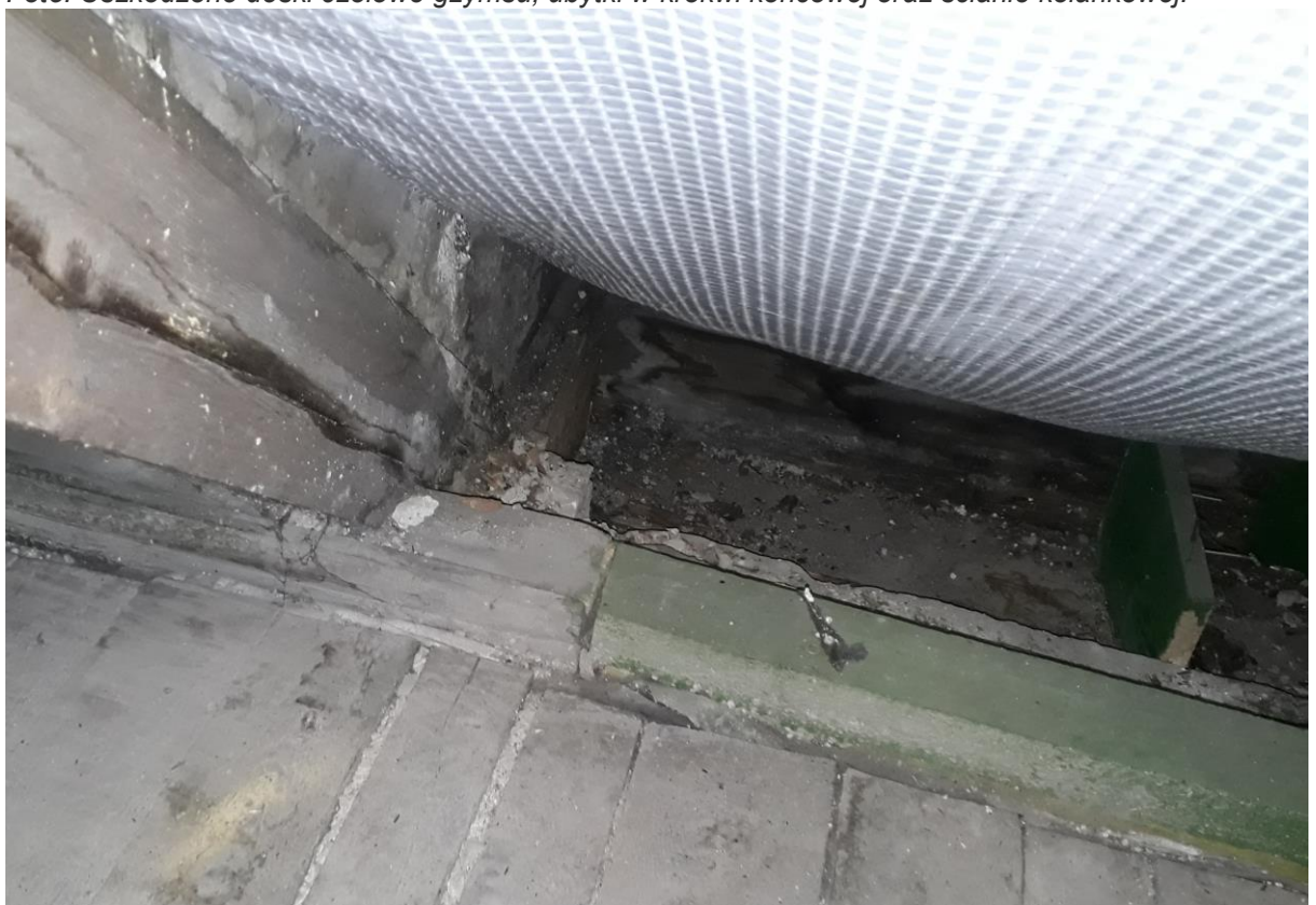
Fot5: Uszkodzone deski czołowe gzymsu, ubytki w krokwi końcowej oraz ścianie kolankowej:
